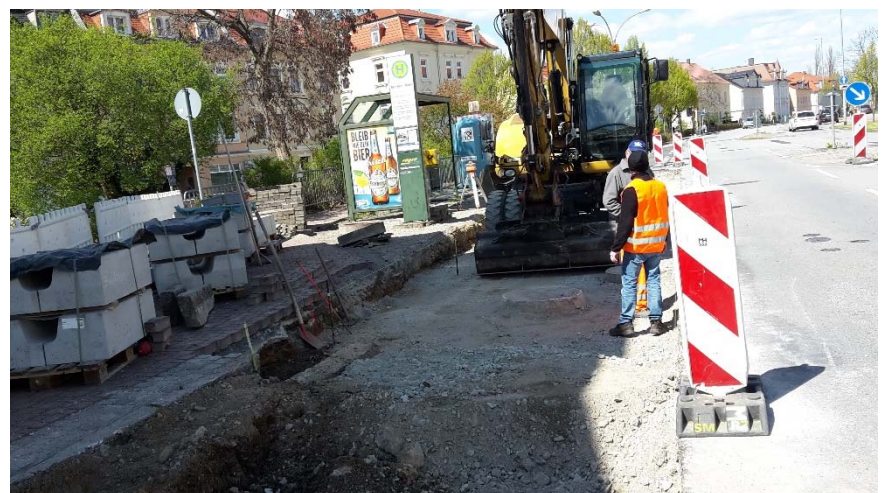
Grundhafter Ausbau Busbucht: Granitpflaster auf Dränbeton
